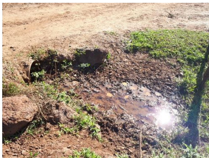
Imagem 20- Detalhe do bueiro instalado no acesso do tributário TG24A.
