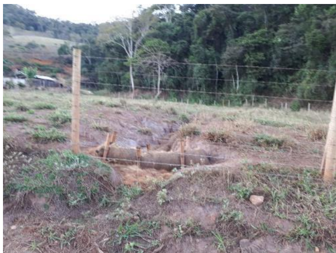
Imagem 68- Sistema de drenagem executado a montante do ITG36.
