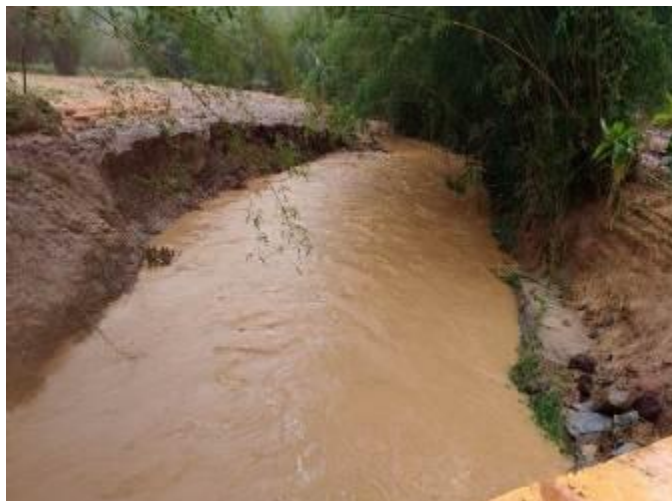
Imagem 35- Situação de trechos mais críticos do TC02 após as chuvas- Danos aos serviços de bioengenharia já executados.
