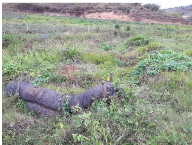
Imagem 15- Detalhe de drenagem de planície aplicada no tributário TG30B.
