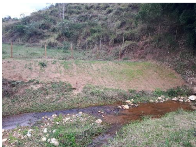
Imagem 24- Detalhe de aplicação da biomanta.
