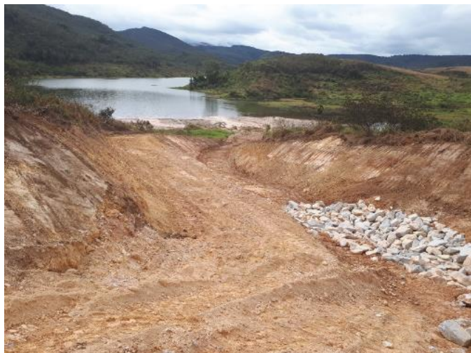
Imagem 71- Canal retaludado com enrocamento em andamento.
