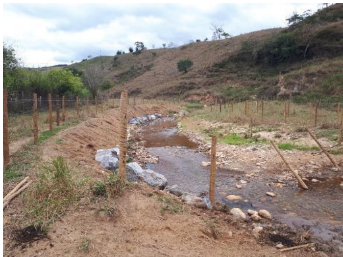
Imagem 22 Limite da área atingida com aplicação de biomantas e cercamento do tributário TG44.
