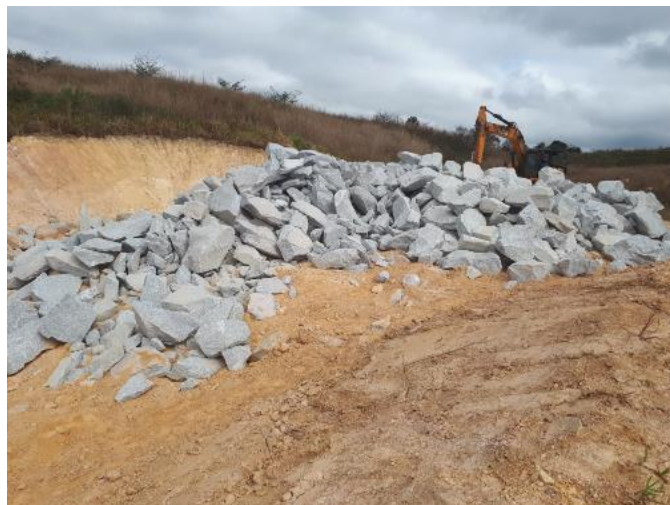
Imagem 72- Enrocamento em andamento.
